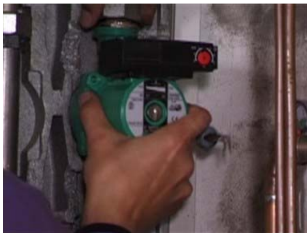
Abbildung: Montage einer Heizkreispumpe
