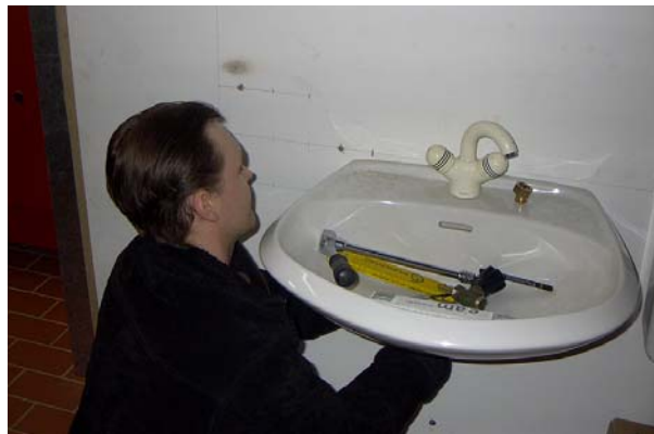
Abb. 11: Eine defekte Waschtischarmatur wird ausgetauscht
